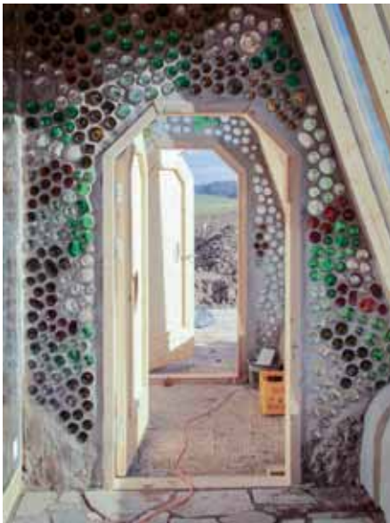
Das deutsche Earthship der Gemeinschaft Tempelhof während der Bauphase. Die Zwischenwände werden aus wärmespeicherndem Altglas hochgezogen
