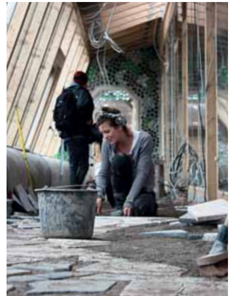
Das deutsche Earthship der Gemeinschaft Tempelhof während der Bauphase. Die Zwischenwände werden aus wärmespeicherndem Altglas hochgezogen
