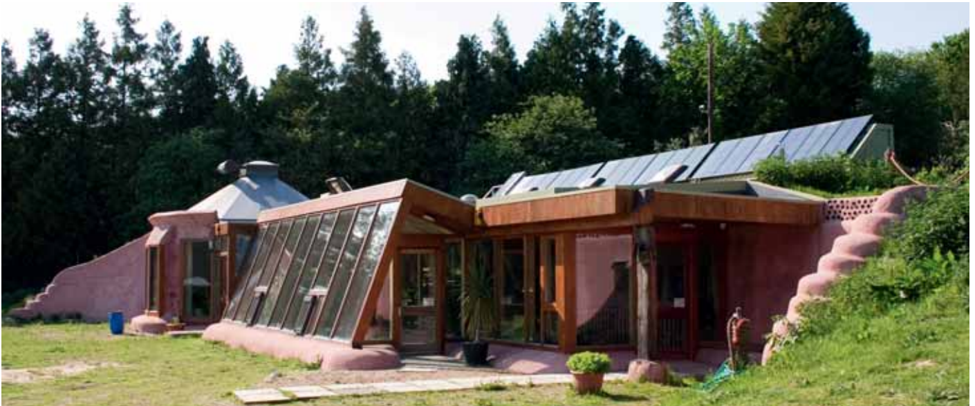
Das Brighton Earthship (das erste in Großbritannien) mit seiner markanten Glasfront in der Grafschaft East Sussex, setzt auf Solarzellen und eine Windmühle zur zusätzlichen Energie-Gewinnung.
