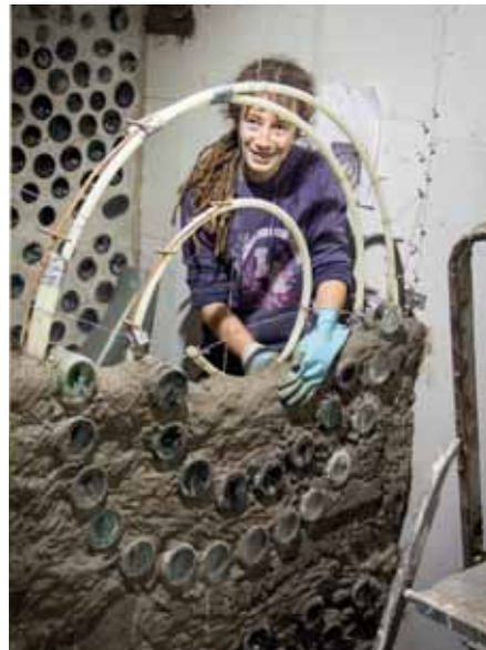
Das deutsche Earthship der Gemeinschaft Tempelhof während der Bauphase. Die Zwischenwände werden aus wärmespeicherndem Altglas hochgezogen
