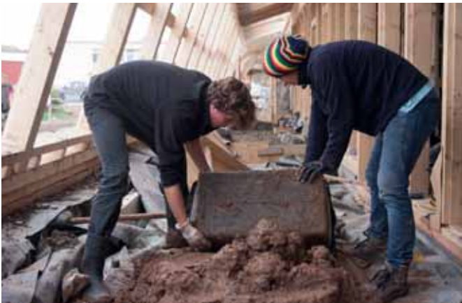
Altreifen, mit Erde verdichtet, bilden den Kern der Außenwände. Konsequenz nach Süden ausgerichtet: die lange Fensterfront des Earthships
